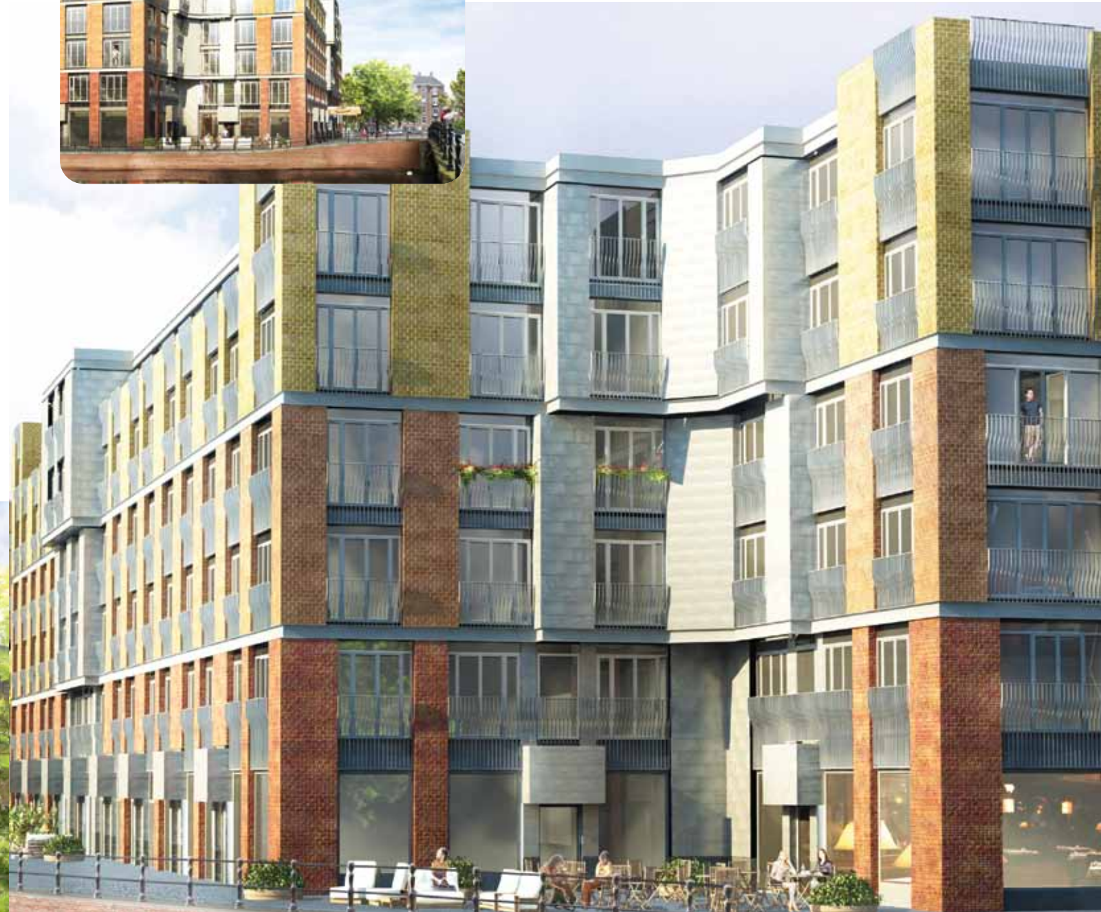
Gevel, gezien vanaf de nassaukade/koekjesbrug
